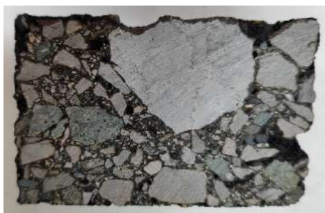
Figura 2: Mezcla asfáltica AC22 BASE 50/70 G CALIZA T3902R
