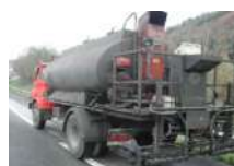
3. Riego con Emulsión
