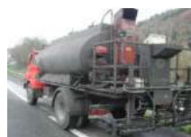
3. Riego con Emulsión
