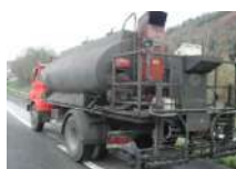
3. Riego con Emulsión
