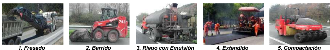
Figura 4. Puesta en Obra de la Mezcla Asfáltica
