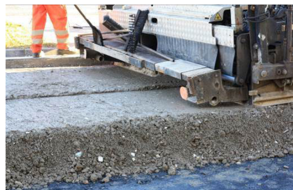
Extendido de gravacemento
