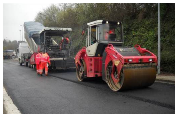
Compactación de la capa de rodadura
