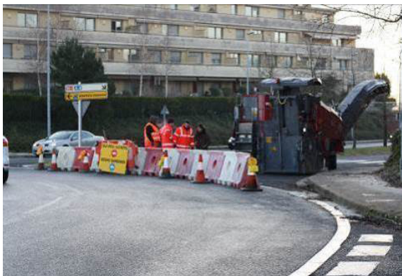
Corte de tráfico a la zona de trabajo
