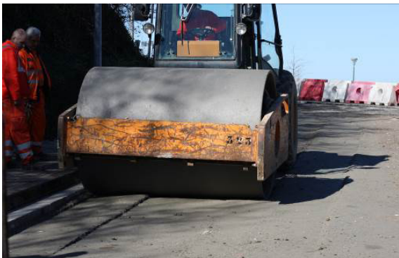
Compactación de la gravacemento
