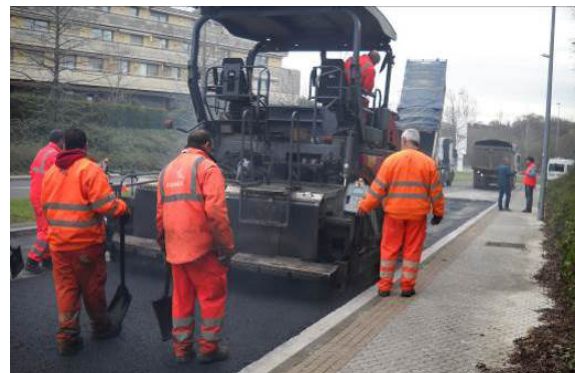
Extendido de la capa de rodadura
